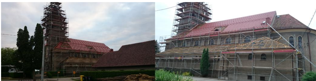
Rysunek 9. Gmina Turawa: Wymiana pokrycia dachowego na kościele pw. Św. Józefa Robotnika w Węgrach
