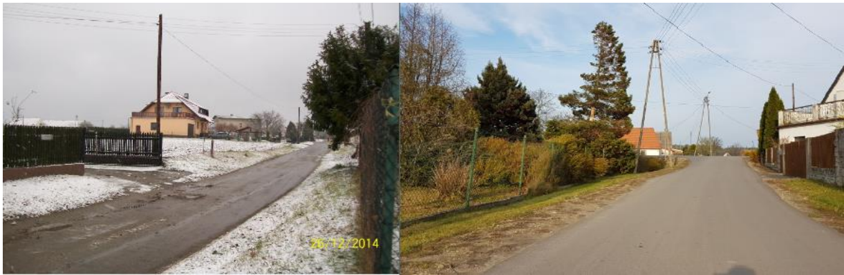
Rysunek 3. Gmina Turawa: zdjęcia dot. remontu ul. Dębowej w Bierdzanach.
