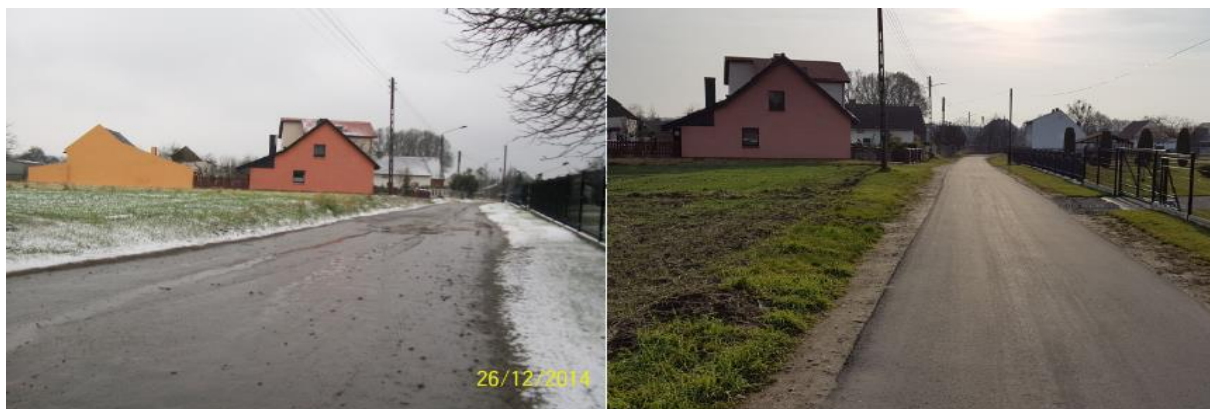
Rysunek 2. Gmina Turawa: zdjęcia dot. remontu ul. Dębowej w Bierdzanach.
