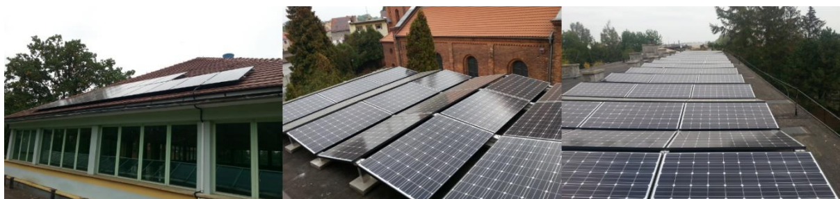
Rysunek 12. Gmina Lewin Brzeski: instalacje fotowoltaiczne na budynkach szkoły podstawowej i gimnazjum w Gminie Lewin Brzeski
