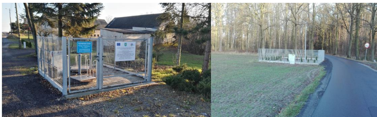
Gmina Krapkowice Budowa kanalizacji sanitarnej w Pietnej. W ramach projektu wybudowano 5 739 mb kanalizacji oraz 2 przepompownie.
