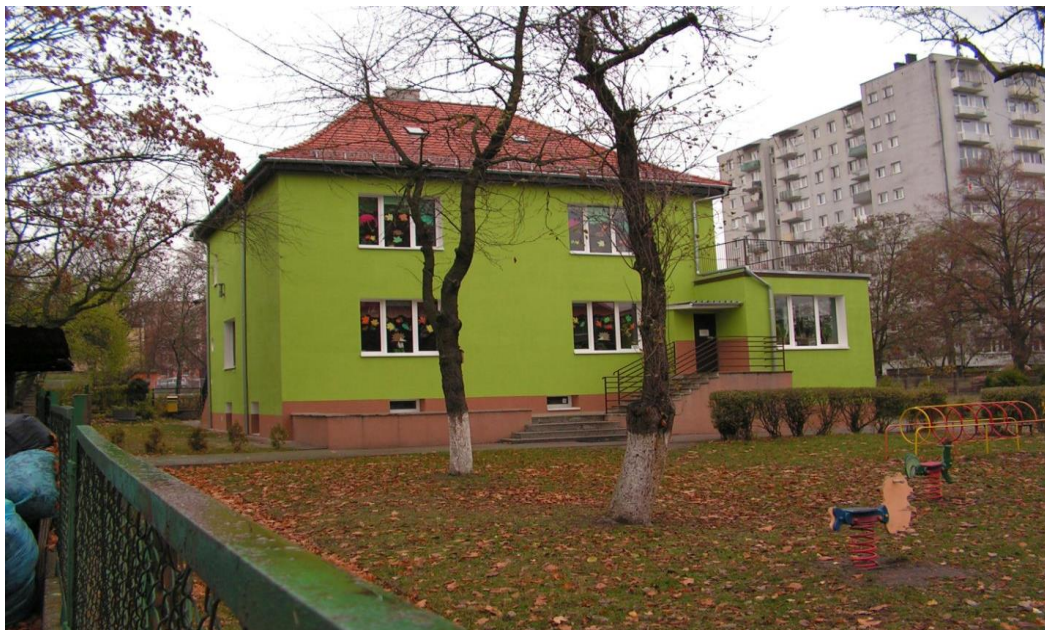
Rysunek 31. Miasto Opole: Przedszkole publiczne nr 18 – Termomodernizacja budynku
