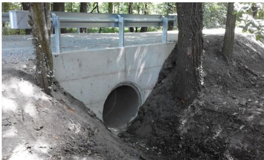
Rysunek 12. Gmina Strzeleczy: Remont przepustu drogowego w Mosznej
