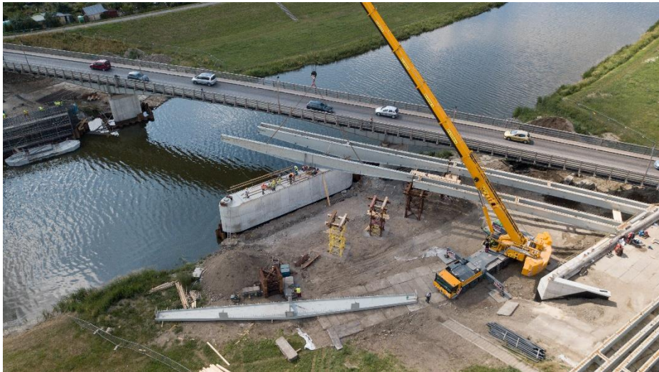
Rysunek 5. Miasto Opole: Bezpieczny transport w Opolu – budowa mostu na ul. Niemodlińskiej w Opolu
