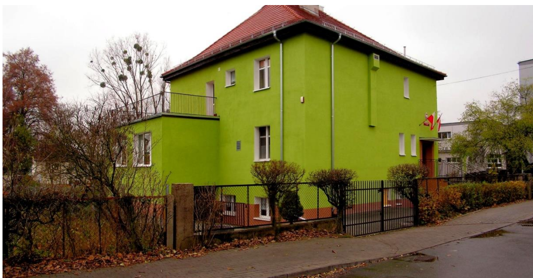
Rysunek 32. Miasto Opole: Przedszkole publiczne nr 18 – Termomodernizacja budynku
