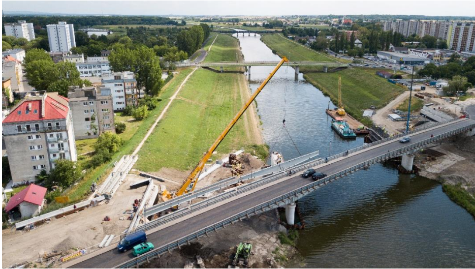
Rysunek 4. Miasto Opole: Bezpieczny transport w Opolu – budowa mostu na ul. Niemodlińskiej w Opolu
